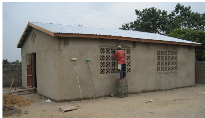
Het nieuwe lokaal in aanbouw
